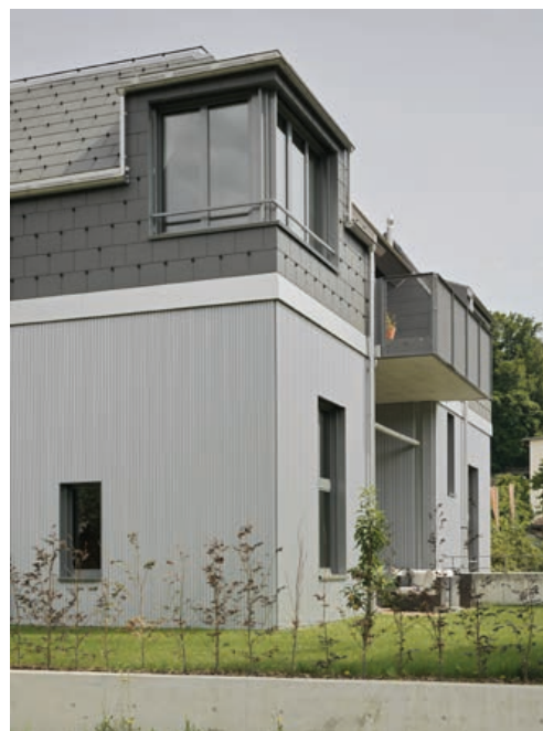
Ersatzneubau Zweifamilienhaus, Ebikon 2020 – 2021 Privat
